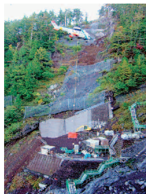
源頭域調査工事現場
