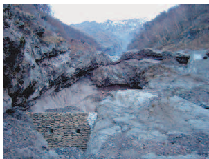
平成16年度施工の4の滝保護工
