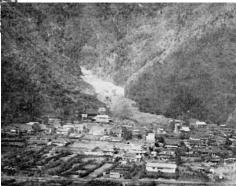
土石流で崩壊した西湖地区
