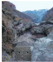
平成16年度 富士山源頭域調査工事
