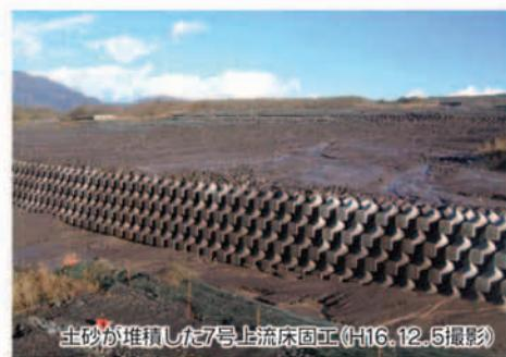
土砂が堆積した7号上流床固工(H16.12.5撮影)
