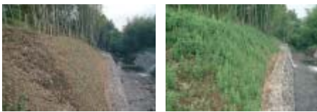
工事完成後(平成15年3月) 完成3ヶ月後(平成15年6月)
