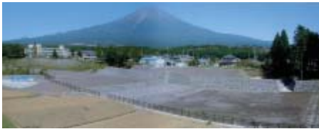
猪の窪川渓流保全工事完成写真(平成15年9月)
