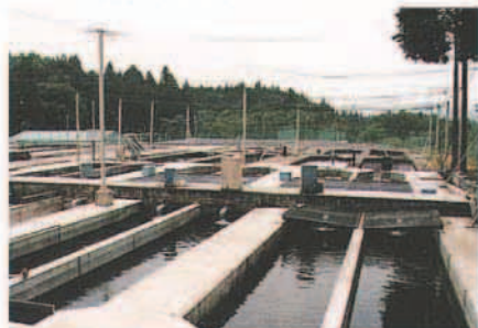
写真：静岡県水産試験場富士養鱒場 システム養魚池
