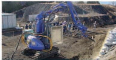
去る1月31日、無人化施工の現地検討会を開催しました。富士砂防工事事務所では、源頭部調査工事における作業の安全対策として、法面吹付工に無人化施工を導入する検討を行っています。
