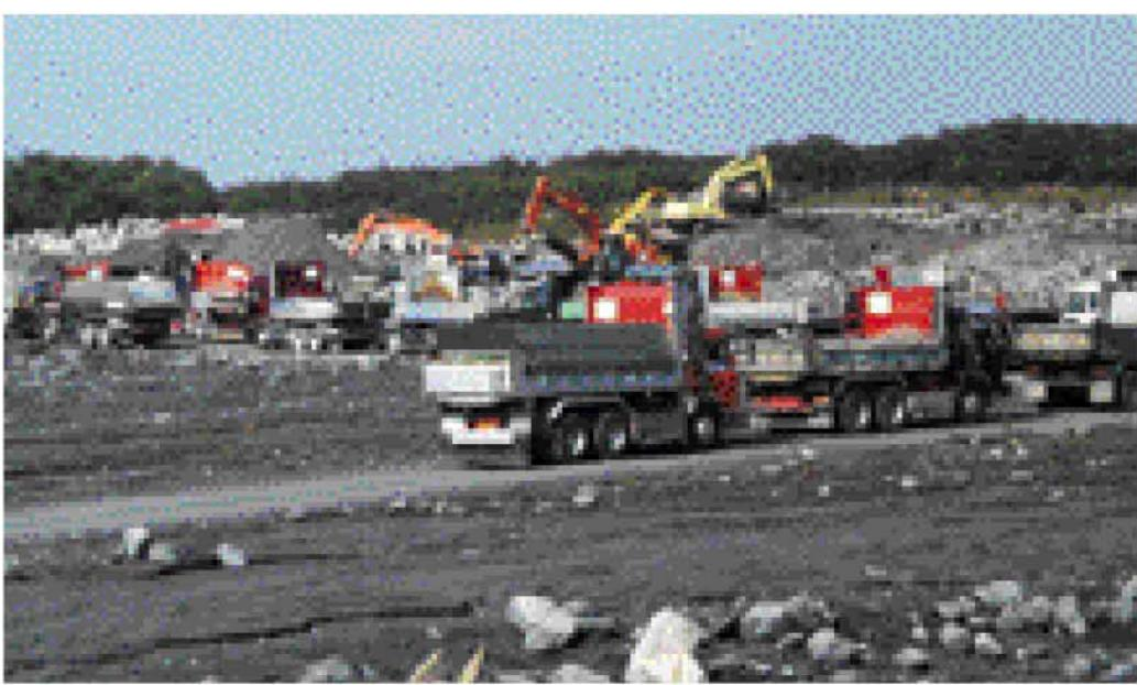
▲第7号床固工除石状況——最大1日あたり120台のダンプトラックがのべ500台運搬しました。
