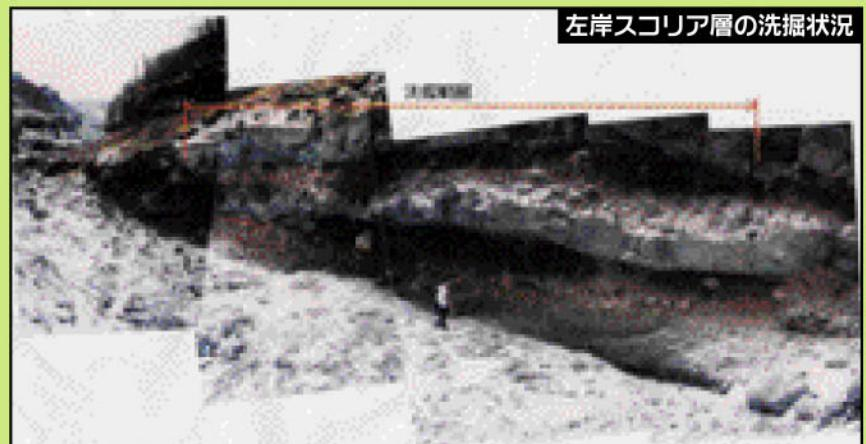
平成12年11月21日に発生した記録的な土石流により、調査工事現場の左岸渓岸のスコリア層がえぐられる様に洗掘されました。溶岩層の崩壊も著しく、これに対し早急にスコリア層を補強することが課題となっています。また、右岸斜面(A斜面)は、昨年から小崩壊が多発し、5月中旬においても高さ約5m・幅約10mにわたり崩壊していることが確認され、緊急な対策が必要となっています。
