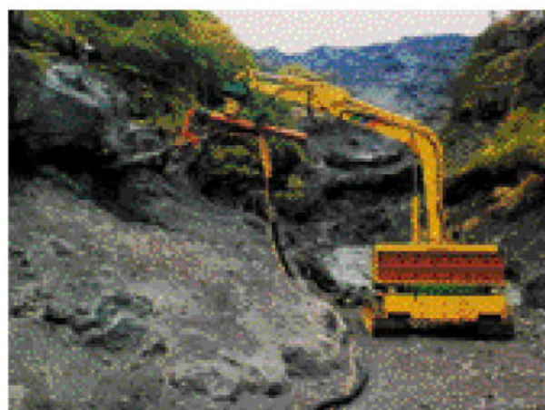
大沢川源頭部調査工事（スコリア層の補強）▲
