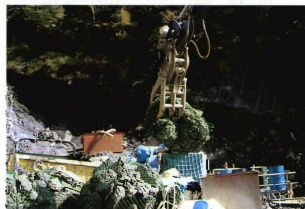
中詰材をつかむ装置（遠隔化施工）
