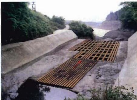
岩面底面水抜きスクリーンダム
