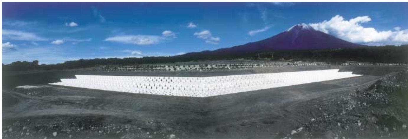
大沢崩れから発生する土石流の土砂を、大沢川遊砂地で捕捉する目的で、遊砂地の最上流部に位置する第9床固工を補強する落差工が完成しました。
