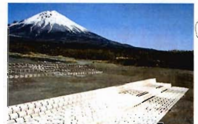
大沢川遊砂地落着工
