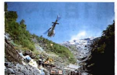
富士山源頭部調査工事
