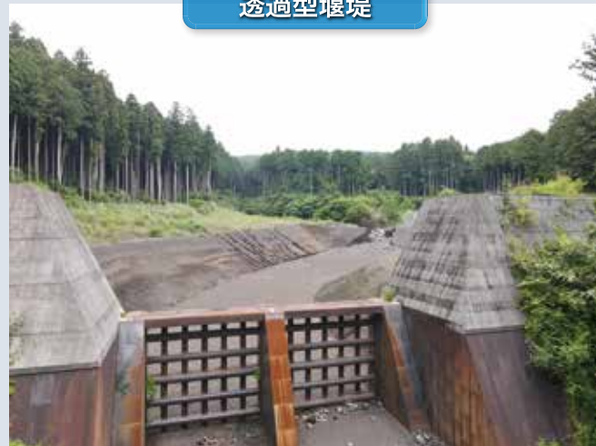
風祭第1堰堤(静岡県富士宮市山宮地先)
