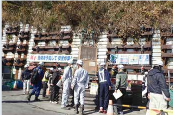
深礎杭の工事現場の安全対策に不備がないかを確認
