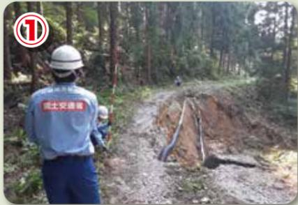
① 林道崩落箇所の調査では、道路だけでなく埋設管等の被災も見られました。
