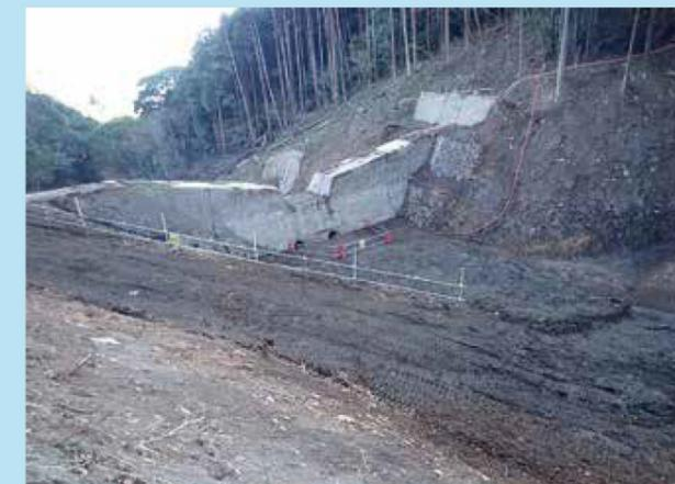
① 既設砂防堰堤の除石完了
