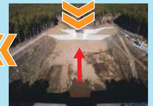
⑦上流床固工施工
