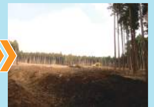
②工事箇所伐採(H26.10開始)
