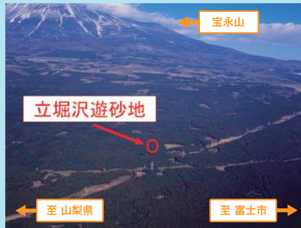
①施工箇所の周辺状況
