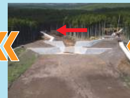
⑧導流堤施工
