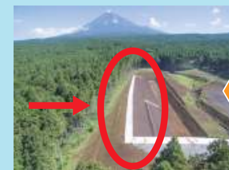
④右岸側の堤防施工
