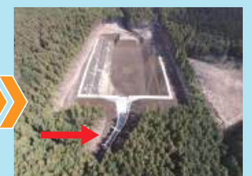
⑥前庭保護工施工
