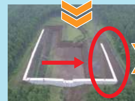
⑤左岸側の堤防施工
