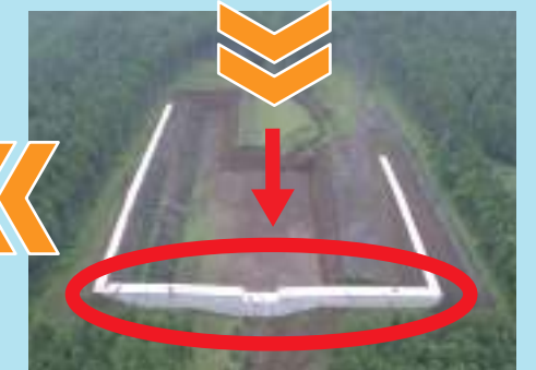
③基幹堰堤施工
