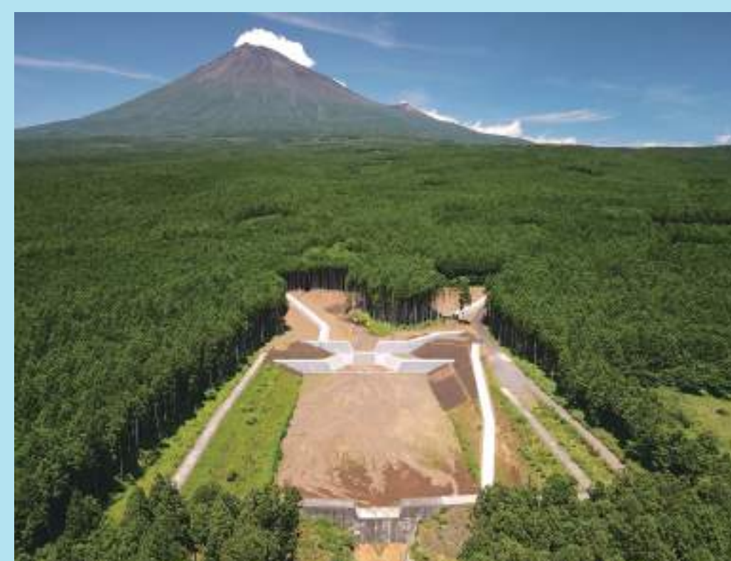
⑨遊砂地工完成(R4.7)
