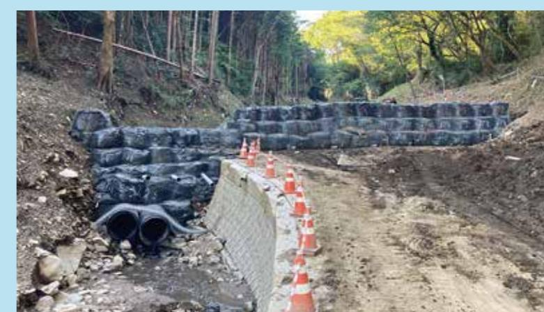
④ネットロール土のう工法を用いた応急仮設堰堤
