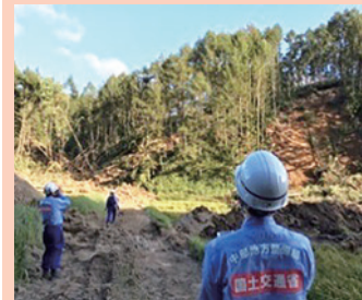
被災状況調査（ドローン）
