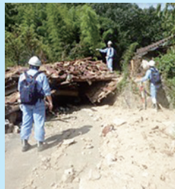
溪流の被害状況調査
