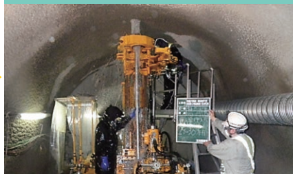
⑤集水ボーリング削孔
