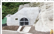
大久保排水トンネル完成
