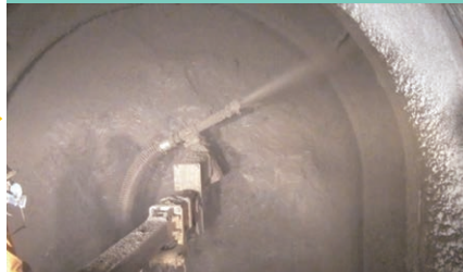
⑤集水ボーリング削孔
