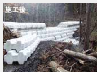
コンクリートブロック堰堤 (H26御嶽山)
