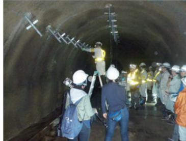
すべり面より下の丈夫な地層にトンネルを設け、トンネルから設置したパイプにより、地中深い場所の地下水を取り除きます。
