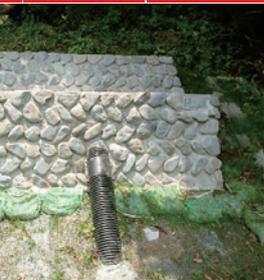
山崩れ方向に孔を開けて設置したパイプにより、浅い位置の地下水を取り除きます。
