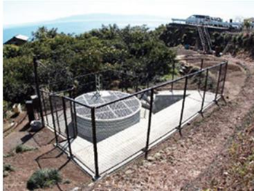
井戸を設け、井戸の周りに放射状に設置したパイプにより、移動する土の比較的深い場所の地下水を取り除きます。
