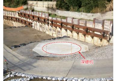
地下に大きな杭を造り、杭により地すべりの移動を止めます。
