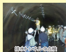
排水トンネルの点検
