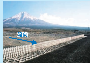
大沢川遊砂土工 第7上流床固め工
