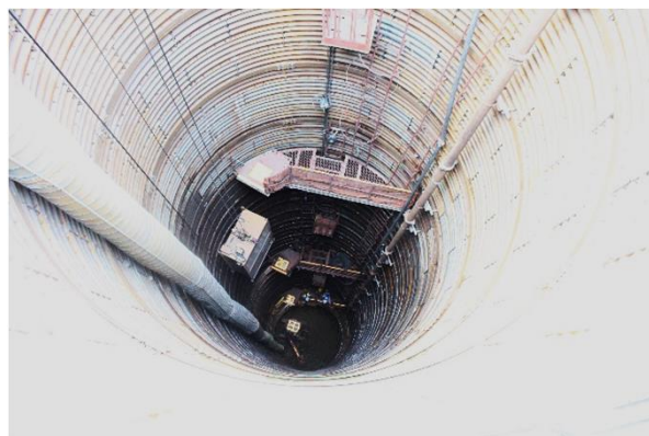
深礎杭工事現場の見学
