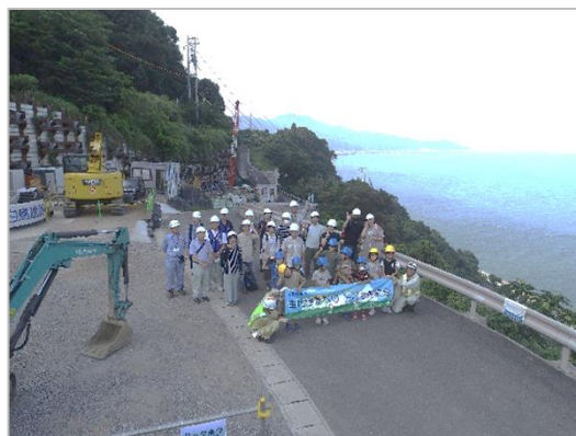
工事現場での集合写真
