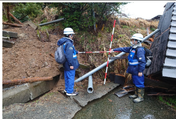
石川県輪島市縄又町 被災状況の調査
