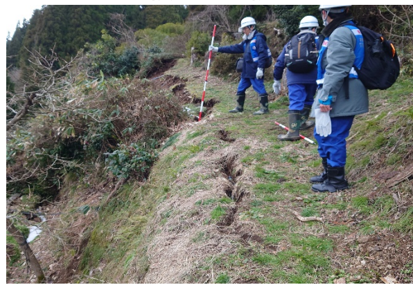
石川県輪島市縄又町 被災状況の調査
