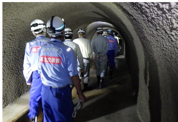
排水トンネルの集水室へ移動
