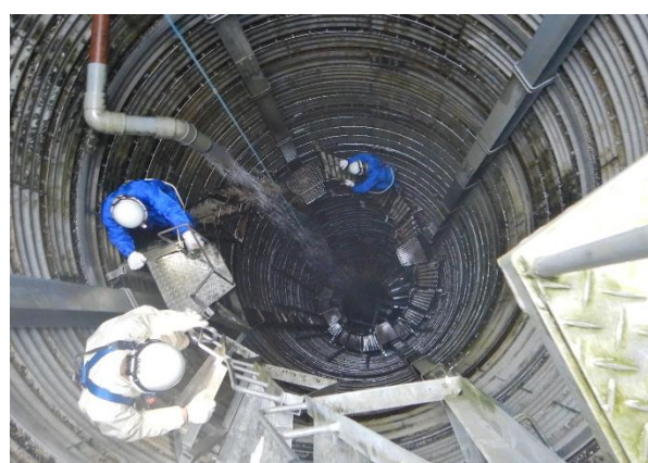
集水井点検のため井戸内へ移動
