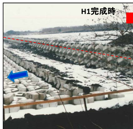
③第9床固工付近 流出土砂により床固工は埋まり、ブロックは一部損傷・流出している。
