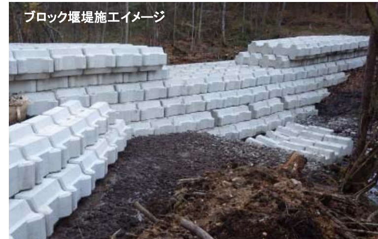
ブロック堰堤緊急施工事例 (御嶽山 ブロック堰堤)
