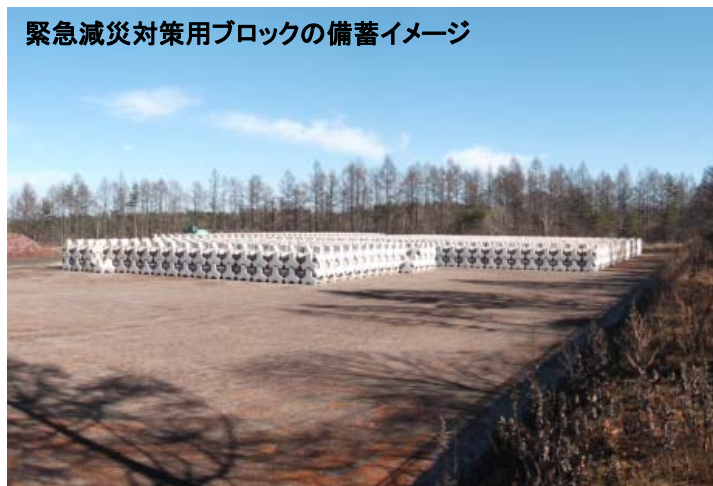
火山噴火緊急減災対策事例 (浅間山 砂原ストックヤード)
