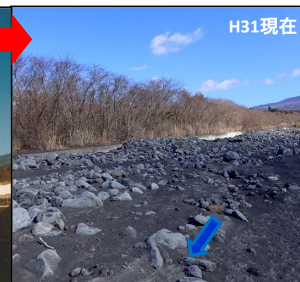
②溪岸工区間 度重なる土砂流出により護岸天端まで土砂が堆積
