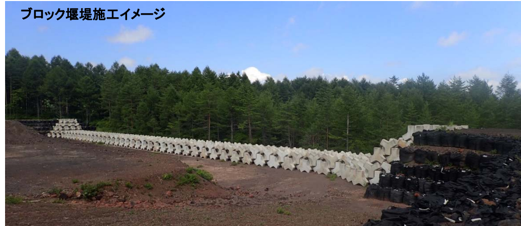
ブロック堰堤緊急施工事例 (浅間山 ブロック堰堤)
