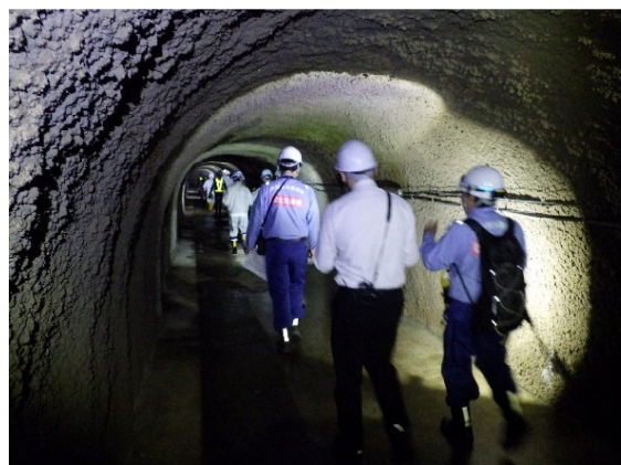
排水トンネルの集水室へ移動
