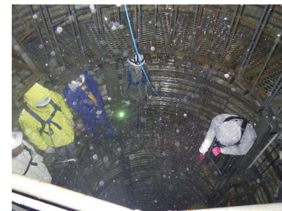
集水井内で点検実施
