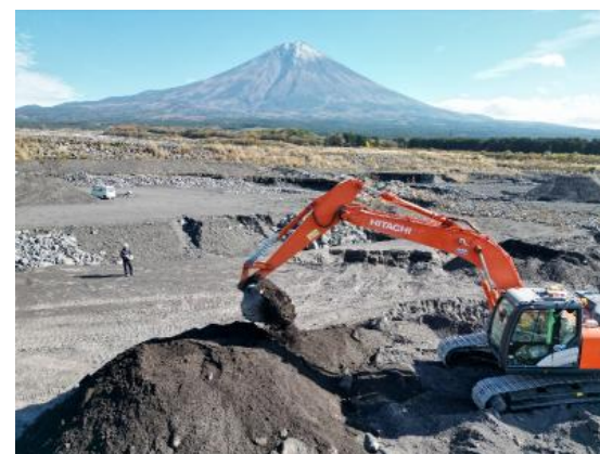
無人化施工バックホーで 導流堤（L60m×B12m×H2m）の試験施工
