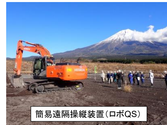
無人化施工バックホーで 導流堤（L60m×B12m×H2m）の試験施工
