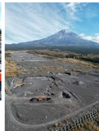
無人化施工バックホーで 導流堤（L60m×B12m×H2m）の試験施工
