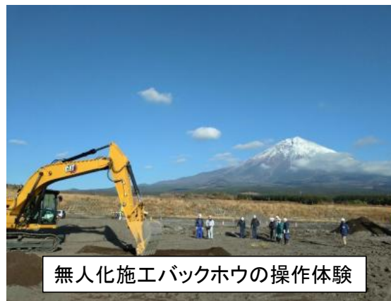
無人化施工バックホーで 導流堤（L60m×B12m×H2m）の試験施工
