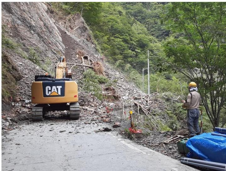
ロボQSによる遠隔操縦での作業状況
