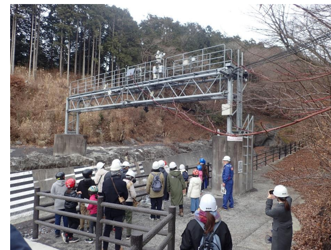
岩樋(土石流観測施設)の見学・説明
