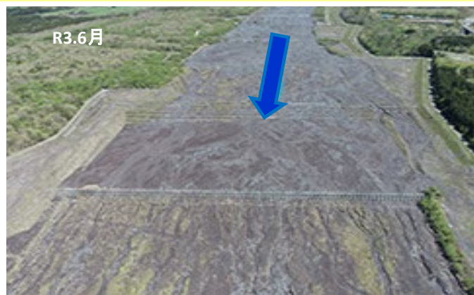
扇状地内の堆積土砂の撤去 第6上流床固 堆砂状況
