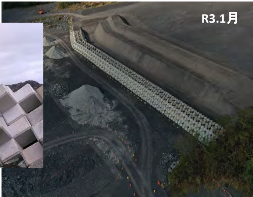
9号床固 ブロック入替完了 上空から望む
