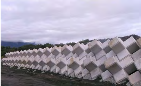
9号床固 ブロック入替完了
