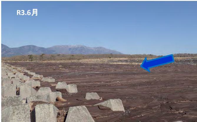
①扇状地内の堆積土砂の撤去 第6上流床固 堆砂状況
