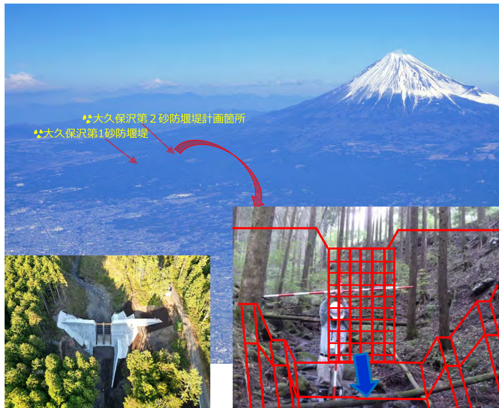
大久保沢第1砂防堰堤 完成写真
