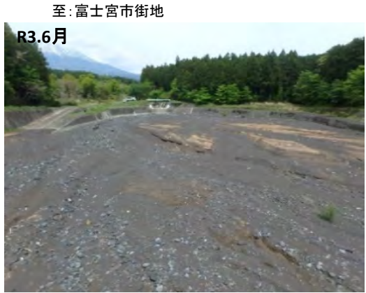
①沈砂地内の堆積土砂の撤去 風祭沈砂地 堆砂状況
