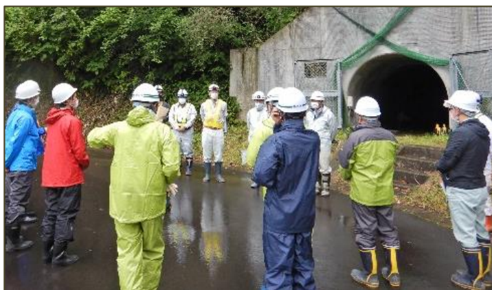
地すべり防止施設 概要説明
