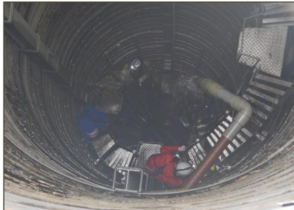
集水井点検のため井戸内へ移動
