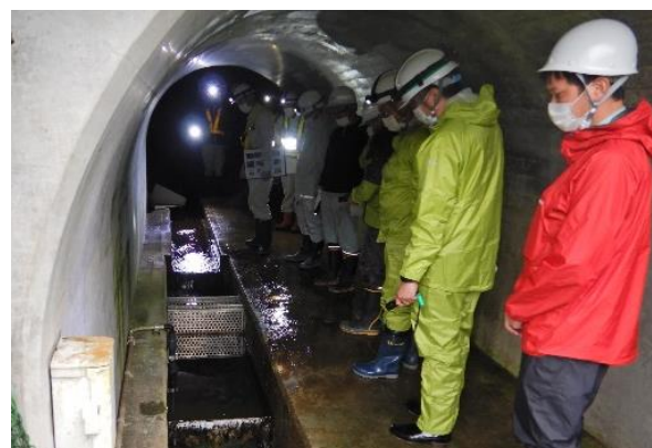
排水トンネルの集水室へ移動
