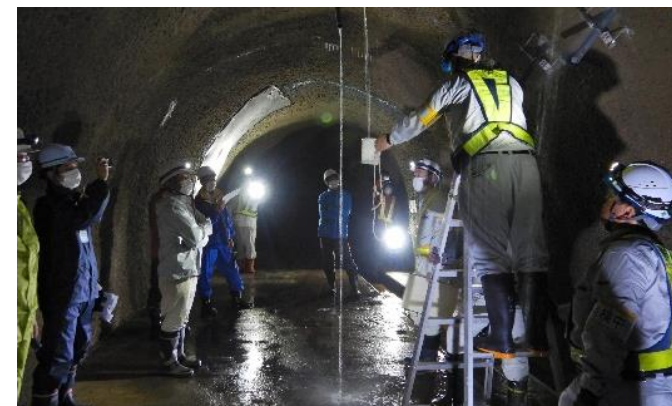
排水トンネル内で排水量測定を実施
