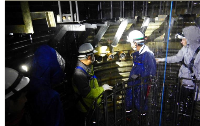
集水井内で点検実施
