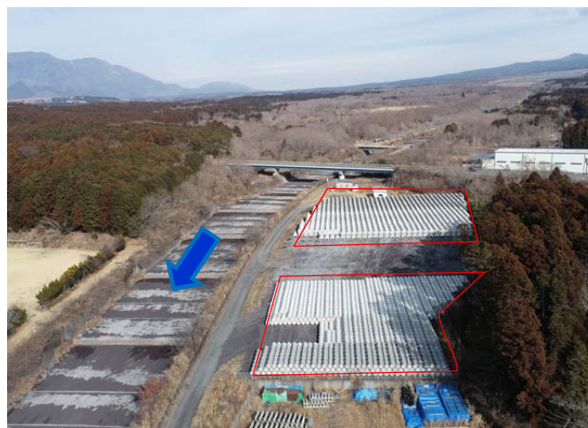
ブロック備蓄ヤードの整備状況 (富士宮市上井出)
