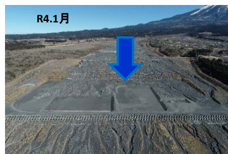
第6上流床固工 堆積土砂を撤去
