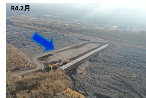
第8床固工 根固ブロック 入替状況
