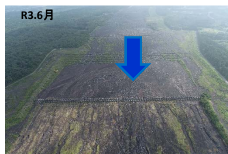
第6上流床固工 堆積土砂を撤去
