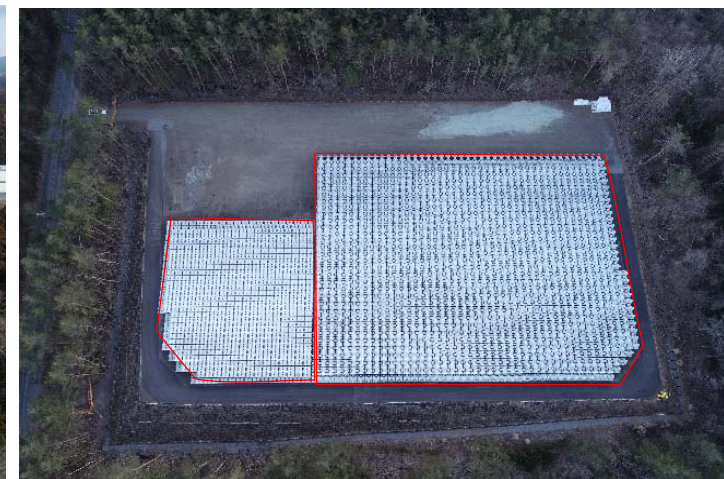
ブロック備蓄ヤードの整備状況 (南都留郡富士河口湖町船津)
