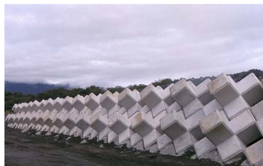
第9床固工 根固ブロック 入替完了
