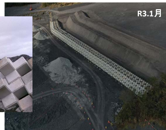
②老朽化施設の補修 ブロック入替 補修例
