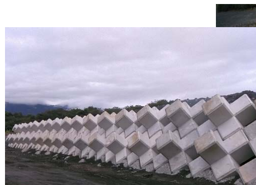
9号床固 ブロック入替完了
