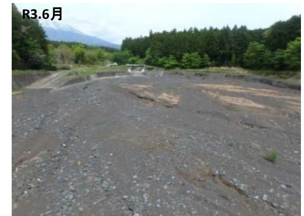
①沈砂地内の堆積土砂の撤去 風祭沈砂地 堆砂状況
