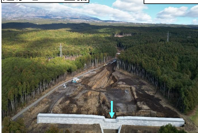
市兵衛沢第1支溪遊砂地工 (静岡県富士宮市粟倉地先)
