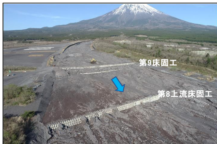
令和6年4月10日 大沢川遊砂地 土石流発生後
