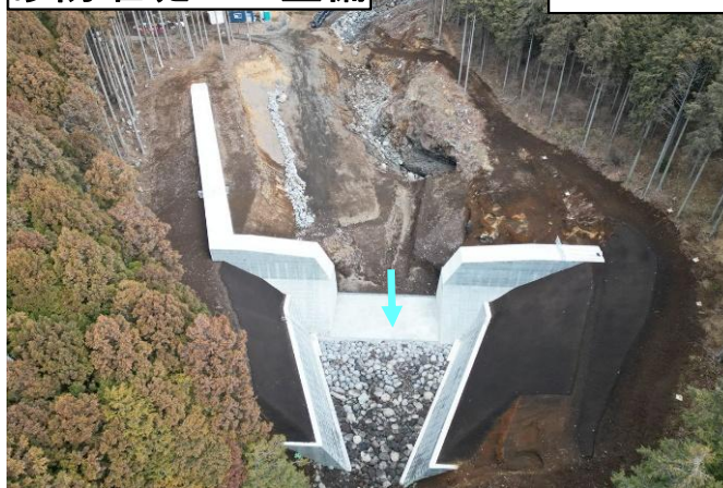
風祭上流第2堰堤工群(風祭第3砂防堰堤) (静岡県富士宮市山宮地先)
