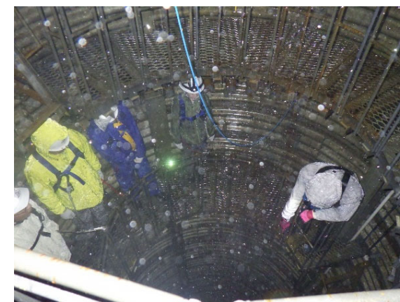
集水井内で点検実施
