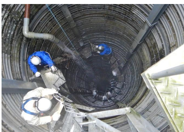
集水井点検のため井戸内へ移動
