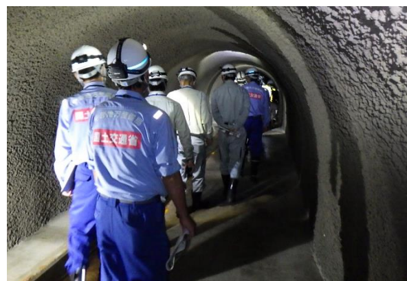
排水トンネルの集水室へ移動
