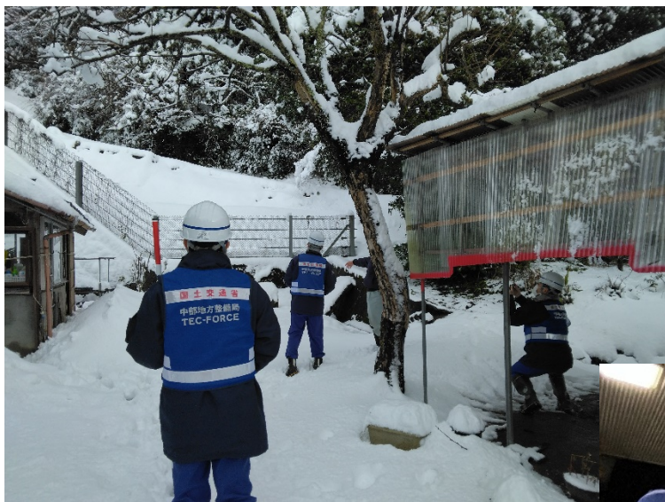
輪島市門前町久川 急傾斜地崩壊危険区域の調査
