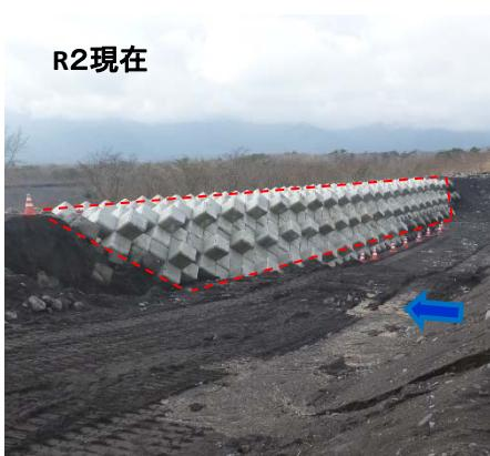
・流出土砂により損傷・流出したブロック
