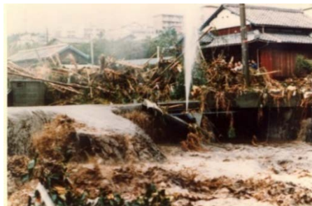
富士市天間地区の被災状況
