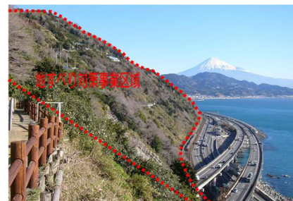
【地すべり対策事業箇所】
