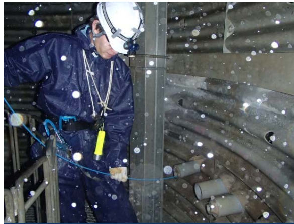
集水井内で点検実施
