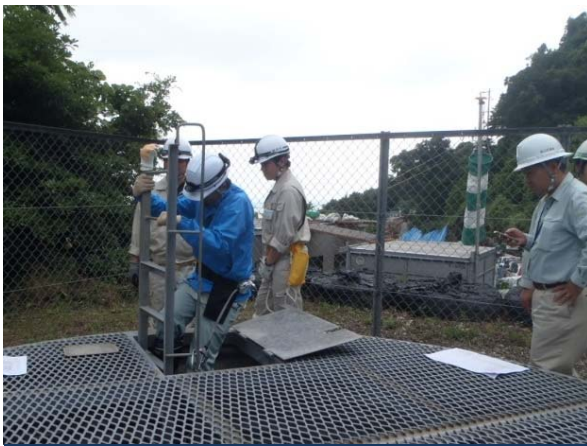
集水井点検のため井戸内へ移動
