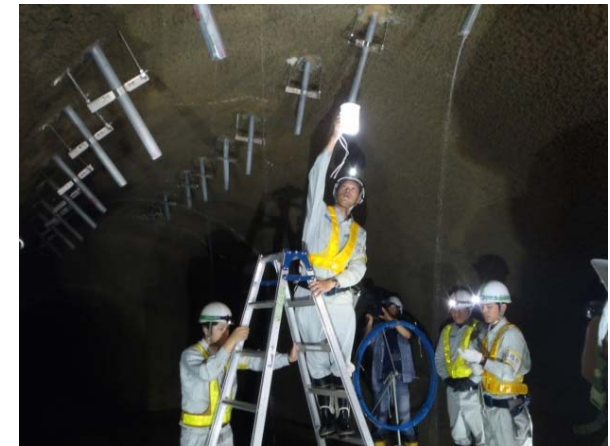
排水トンネル内で点検実施
