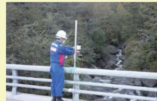
監視カメラの緊急設置 (平成26年御嶽山噴火)
