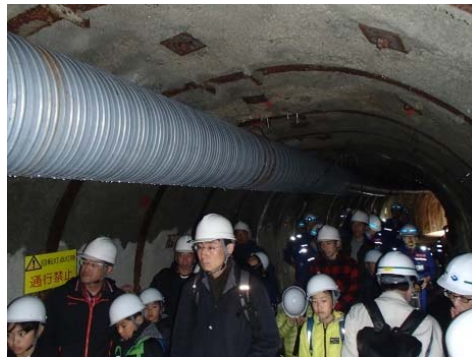
工事中のトンネル入坑
