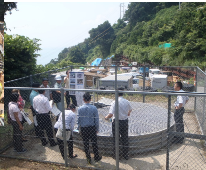
対策施設(集水井)の視察
