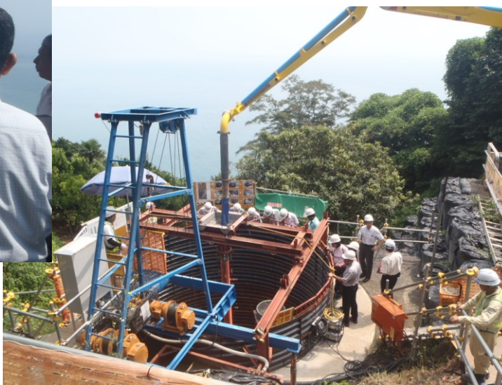
対策施設(深礎杭)施工状況の視察
