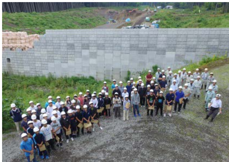
施工中の鞍骨沢遊砂地をバックにUAVを使って記念撮影
