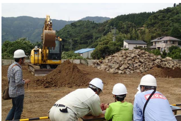
③i-Construction(無人化建設機械操作体験)
