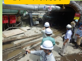
排水トンネル工事現場を見学
